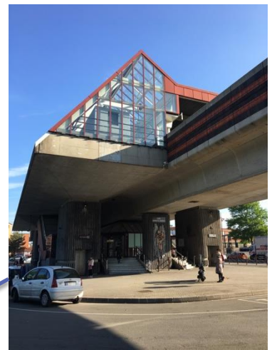
A : Subway station « CHU Centre Oscar Lambret »
