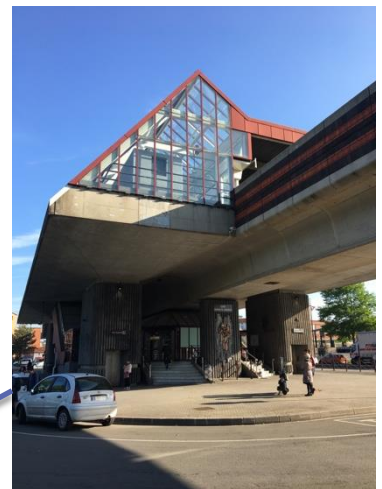
A : Subway station « CHU Centre Oscar Lambret »
